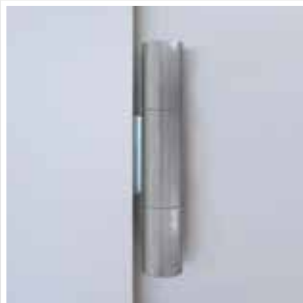
Die Rollenbänder werden ohne Dichtungsunterbrechung montiert.
